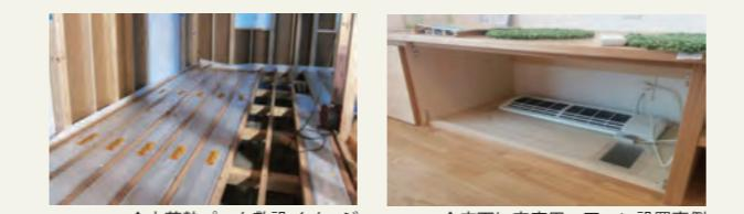
地域の工務店でも施工できる軸組在来工法とした2階建ての木造のボリュームとオープンな空間が交互に並びます。間に掛かる屋根やスラブで、スパンの大きくなる棟や桁、梁に一部鉄骨を使いながら、全体をリング状につなぐ構成です。
